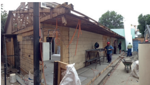
Durante 55 días se ejecutan las obras de esta segunda etapa.
