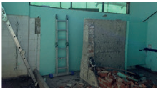
Baño mujeres durante la obra.
