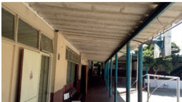
Cubierta de Asbesto Cemento - Antes
