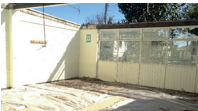
Sala de clases – Durante la obra
