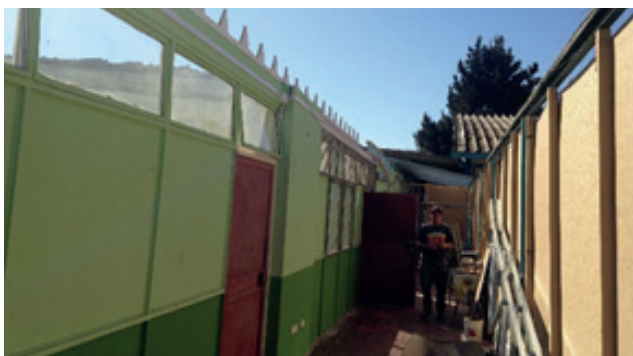
Pabellón E sin la cubierta de A. Cemento
