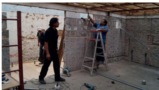
La ampliación trasera se sustentó sobre pilotes de acero para soportar una losa de entramado de paneles de madera.
