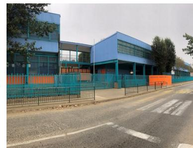
La obra contempló la limpieza, el tratamiento de las fachadas exteriores y luego la pintura exterior de todo el establecimiento. Además del cambio de canales, bajadas de aguas lluvias y reparaciones de aleros en mal estados.
