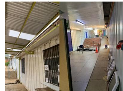
La obra consiste en el mejoramiento de las áreas de sala de espera del recinto, en donde se va a mejorar el pavimento instalando porcelanato, se pintan todas sus fachadas interiores se mejoran rampas instalando barandas de seguridad y en las escalas se pondrán nariz de gradas. Al exterior se mejora cubierta que alberga sala de espera y se cambian luminarias en ambos recintos que se intervienen, por tecnología LED para una mejor eficiencia.
