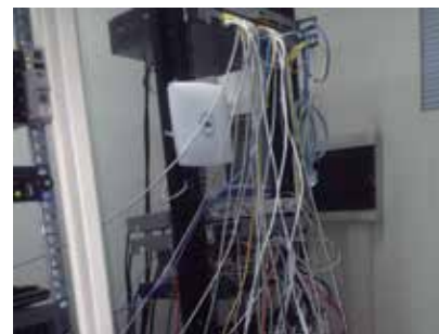
Vista bastidor telecomunicaciones (antes)
