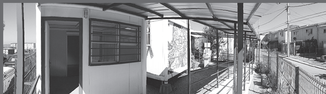
La obra permitirá descongestionar los sectores de espera y flujos de pacientes del PNAC en Cecosf Las Palmas Chilenas.
