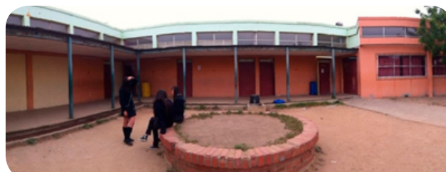
Patio interior antes
