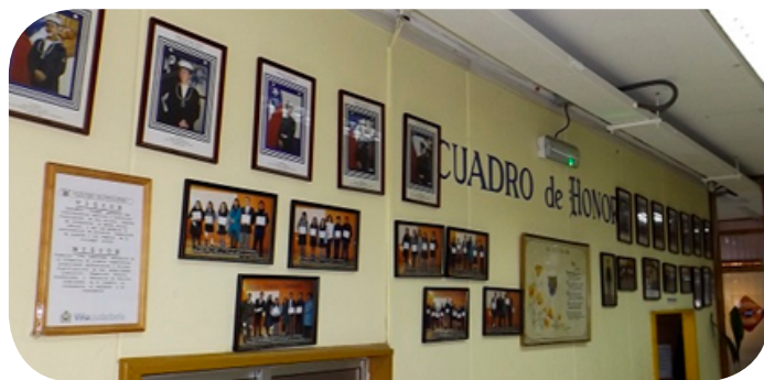
La canaleta superior da cuenta de la reconstrucción realizada del tendido eléctrico de todas las dependencias del Liceo. Asimismo, se efectuaron reemplazos de luminarias interiores.
