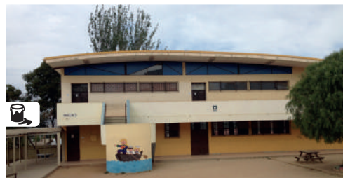
Vista del pabellón antes.
