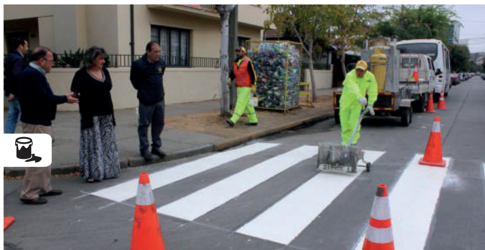
La aplicación de la pintura se hace de noche, y es de material termoplástico y pintura de tráfico.
